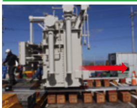
変圧器の移設(ステージ導線)
