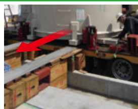
大型タンクの移設(ステージ導線)
