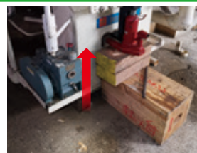
機械ジャッキアップ
