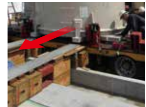
大型タンクの移設(ステージ導線)
