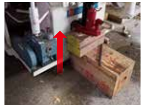
機械ジャッキアップ
