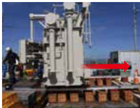
変圧器の移設(ステージ導線)
